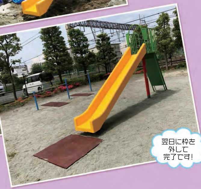
すべり台も 仮設置完了
