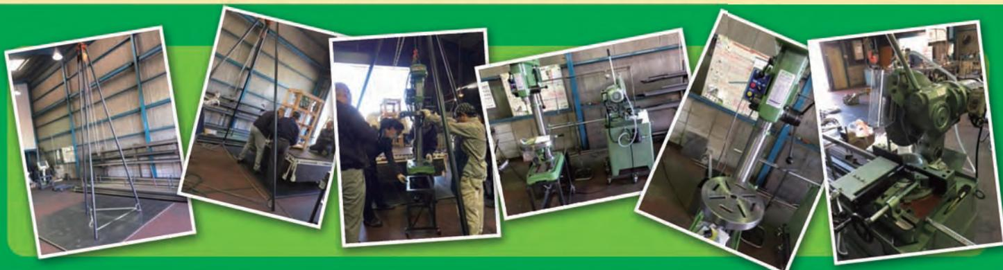
以前の工作機を移動させ搬入スペースを確保します。荷台を用意し、クレーンを備えた大型三脚を設ければ準備は完了です。(ここまでも一苦労です)次にトラックから積荷を降ろします。注意を払いゆっくり静かに作業を行います。荷台に載せた工作機を指定位置に設置すれば完成です。一日掛かりの業務となりましたが無事に工作機の切換えを終えました。
