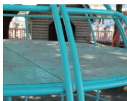
指の挟み込み防止のため、安全基準に 準じた間隔が空いています。
