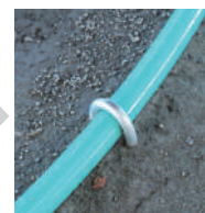
外周のアンカー固定例
