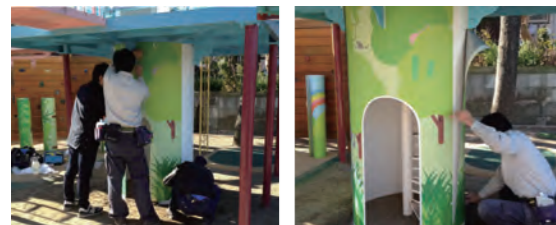
1 ラッピング前にお城のクリーニングと、下地の塗装を行います。
