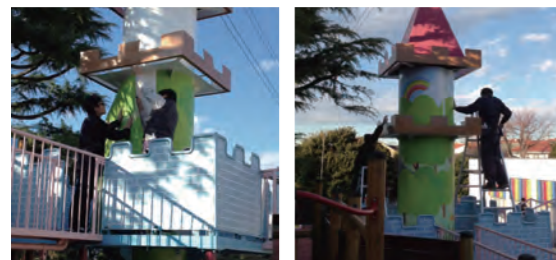
2 お城の 1F~3F まで順番に作業していきます。仕上げの塗装を残してひとまずラッピング施工が完成です。ここまで 1 日作業。翌日、仕上げの塗装を行いました。
