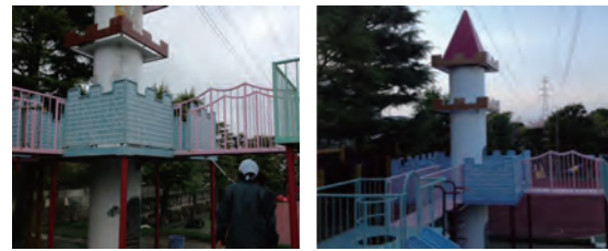
1 ラッピング前にお城のクリーニングと、下地の塗装を行います。
